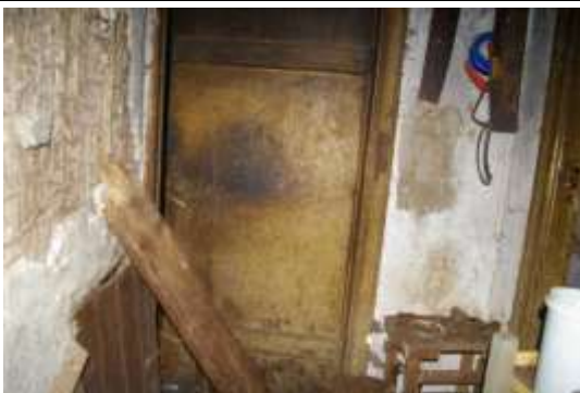
Būve (dzīvojamā ēka) ar kadastra apzīmējumu 6427 002 0367 001
